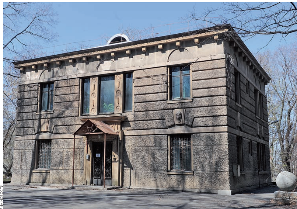
Коттедж директора Института физических проблем. Архитектор Е.Стамо
