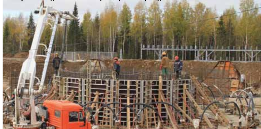
Октябрь 2013 года. Монтаж кольцевого рассолопровода клетового ствола
