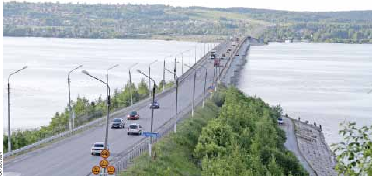
СТРОИТЕЛЬСТВО МОСТА ЧЕРЕЗ ЧУСОВУЮ — КРУПНЕЙШИЙ ПРОЕКТ ГЧП, РЕАЛИЗУЕМЫЙ В ДОРОЖНОМ СТРОИТЕЛЬСТВЕ НЕ ТОЛЬКО В ПЕРМСКОМ КРАЕ, НО И В РОССИИ
