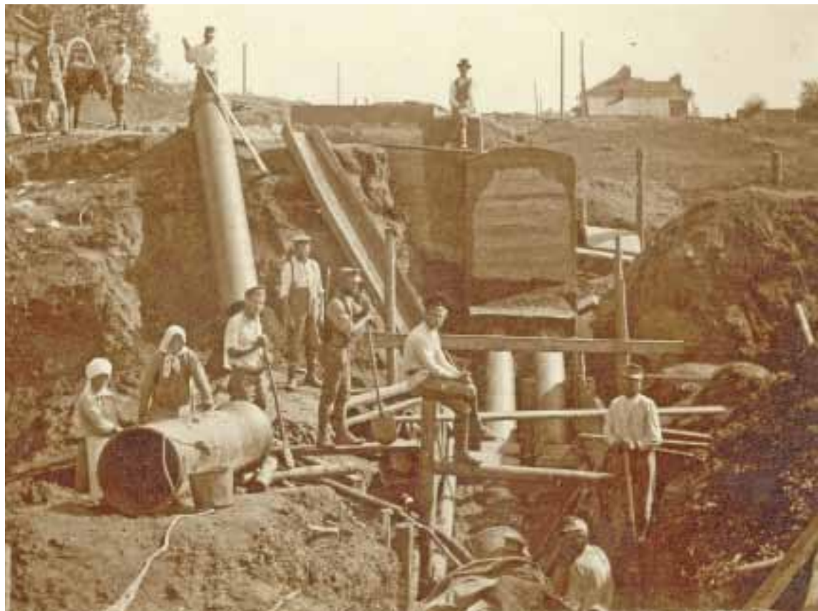
Прокладка канализации в районе набережной. 1917 г.
