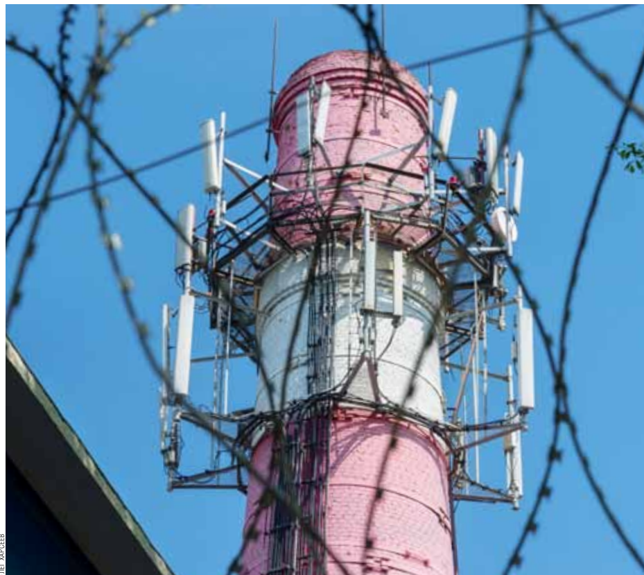
ПЕРМСКИЕ КОТЕЛЬНЫЕ ИЩУТ НОВЫХ ПОСТАВЩИКОВ ГАЗА
