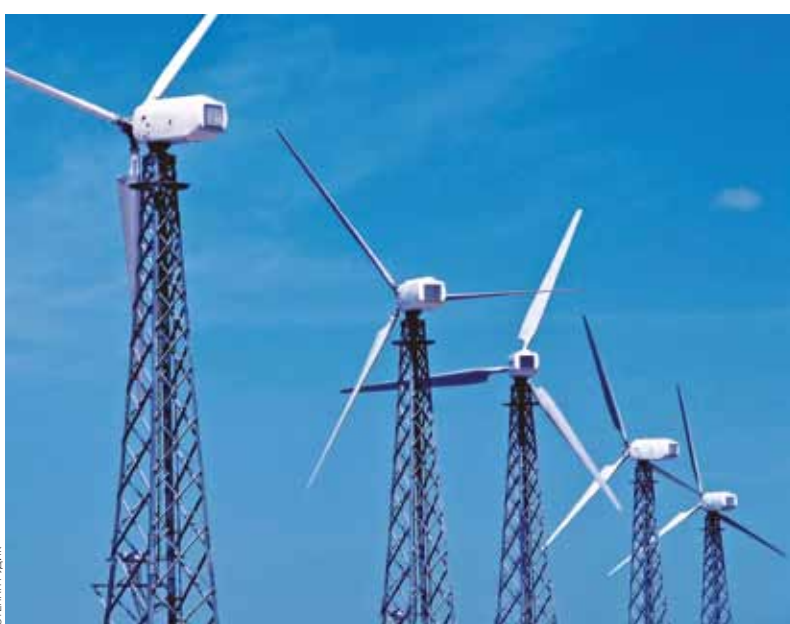
Мощность ветропарка, который инвестор планирует построить в Пермском крае, составит 100 МВт
