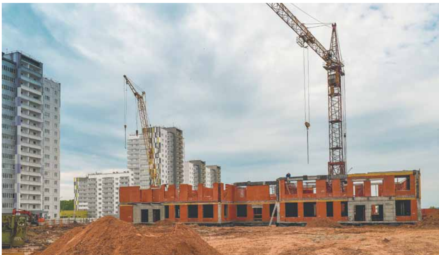
Строительство нового детского сада на улице Евгения Пермяка в Мотовилихе
