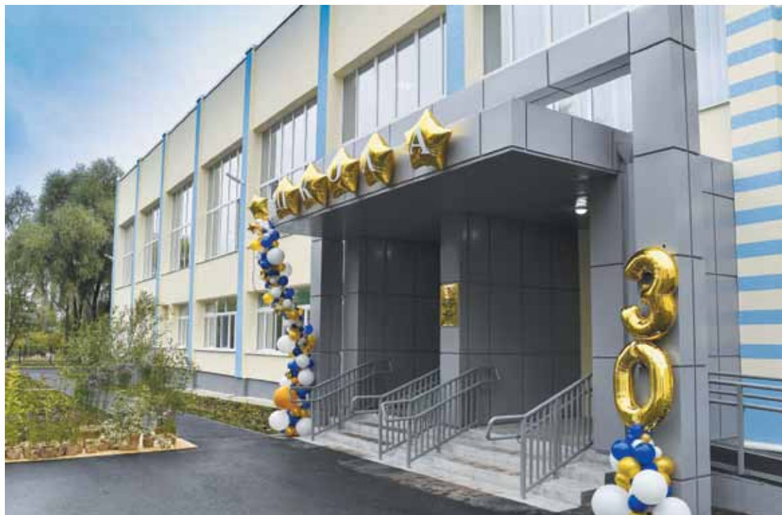
В 2019 году городские власти после капитального ремонта здания открыли новый корпус школы №30 в микрорайоне Вышка II
