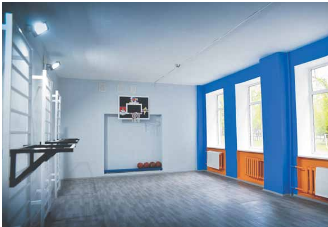
В школе «СинТез» проведен ремонт двух малых спортивных залов, где в следующем учебном году будут проходить тренинговочные занятия по киокушинкай-карате для учащихся спортивных классов начальной школы
