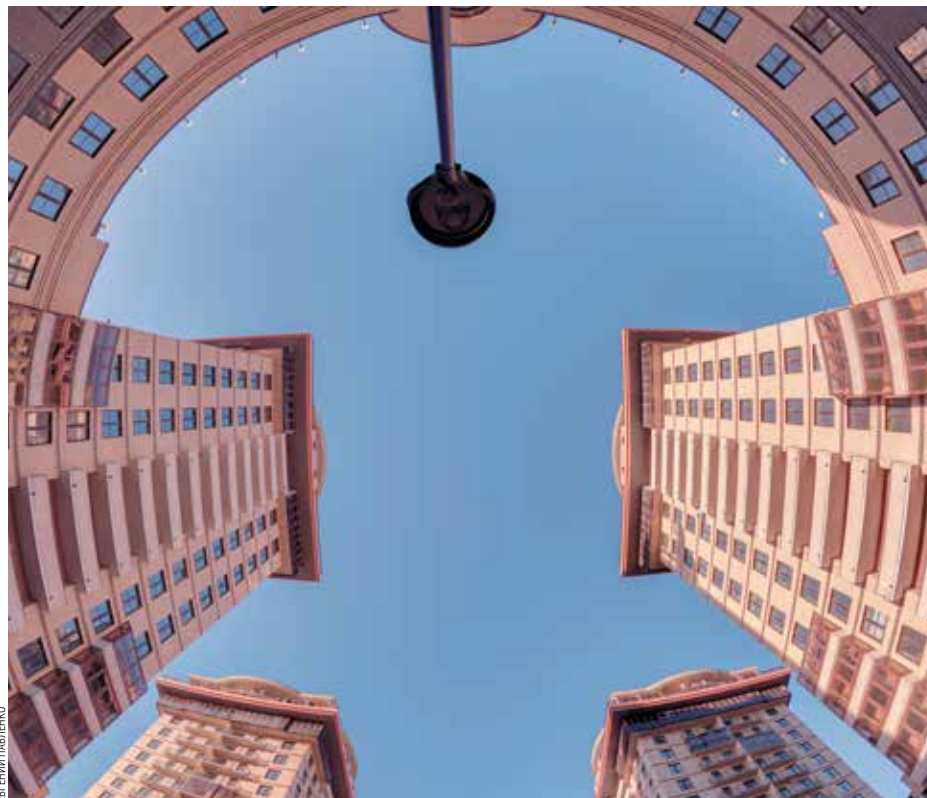
НОВАЯ АРХИТЕКТУРА В СТИЛЕ «СТАЛИНОК» УЖЕ САМА ПО СЕБЕ ГОВОРИТ О ПРОСТРАНСТВЕННЫХ РЕШЕНИЯХ, СВОЙСТВЕННЫХ ЭЛИТНОМУ ЖИЛЬЮ
