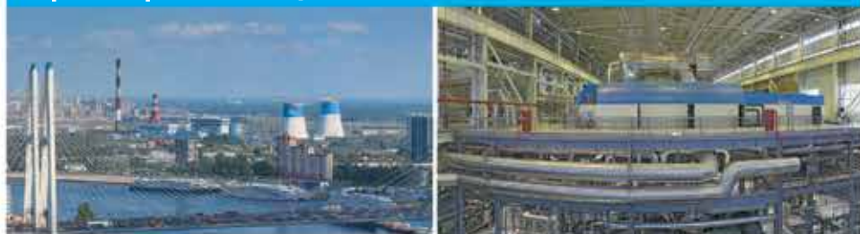
Строительство энергоблока №1, энергоблока №2 ПГУ-450
