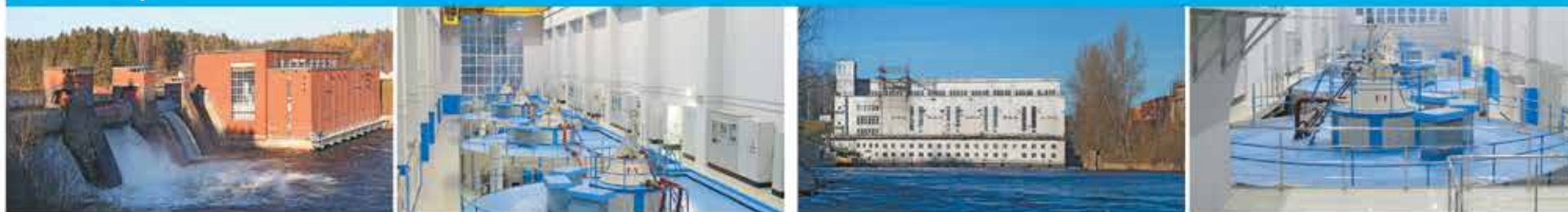
Комплексная реконструкция гидроагрегатов с поэтапной заменой 8 гидроагрегатов и увеличением установленной мощности
