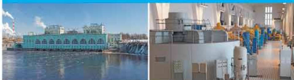
Комплексная реконструкция станции с заменой гидроагрегата №1
