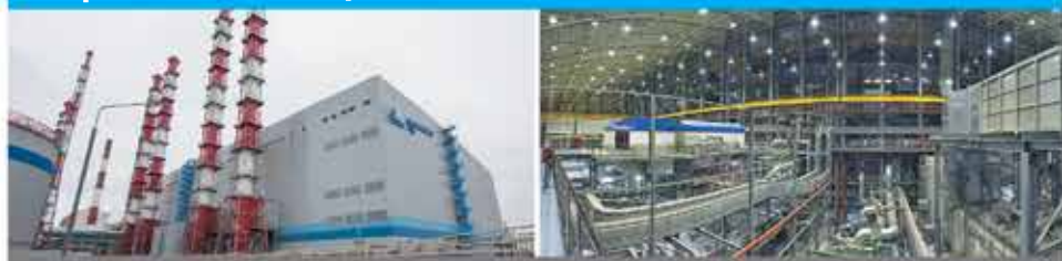
Реконструкция с заменой оборудования: ввод двух ПГУ-180 Ввод нового котельного оборудования
