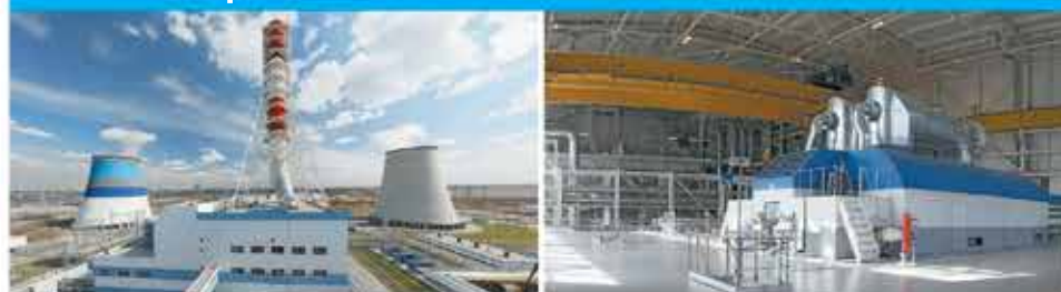
Расширение станции. Строительство энергоблока ПГУ-450
