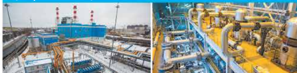
Строительство генерации мощностью 100 МВт на территории ЭС-1
