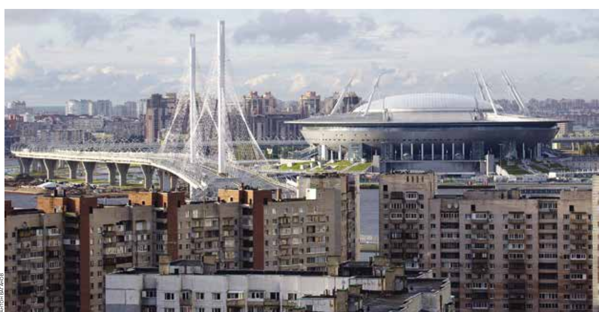
В крупных инфраструктурных проектах генподрядчик практически полностью выполняет строительные работы собственными силами, привлекая субподрядчиков только для выполнения узкоспециализированных работ
