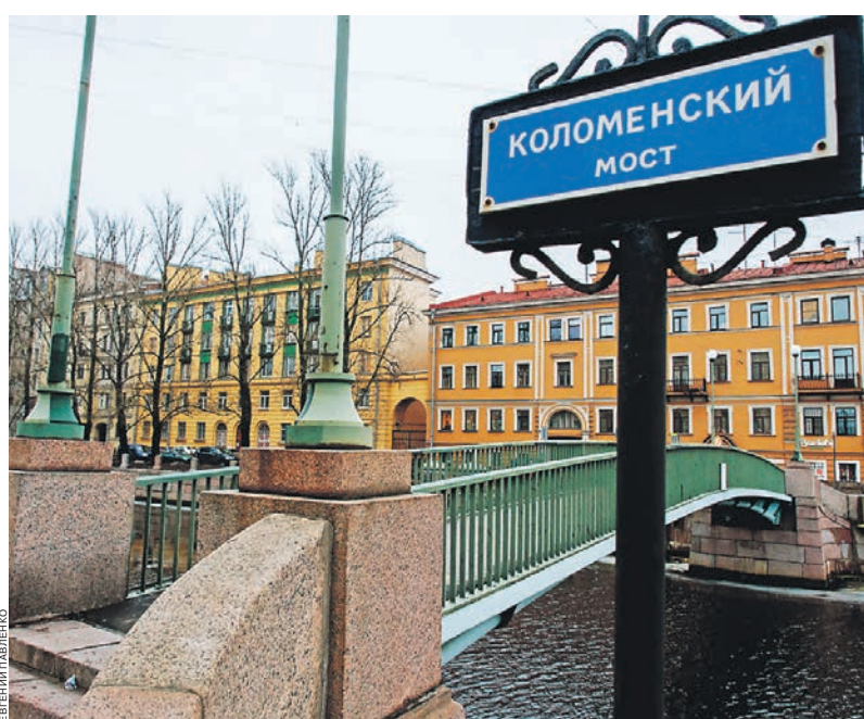
Почти полвека стоит Коломенский мост в Санкт-Петербурге, первый и пока единственный алюминиевый мост в России
