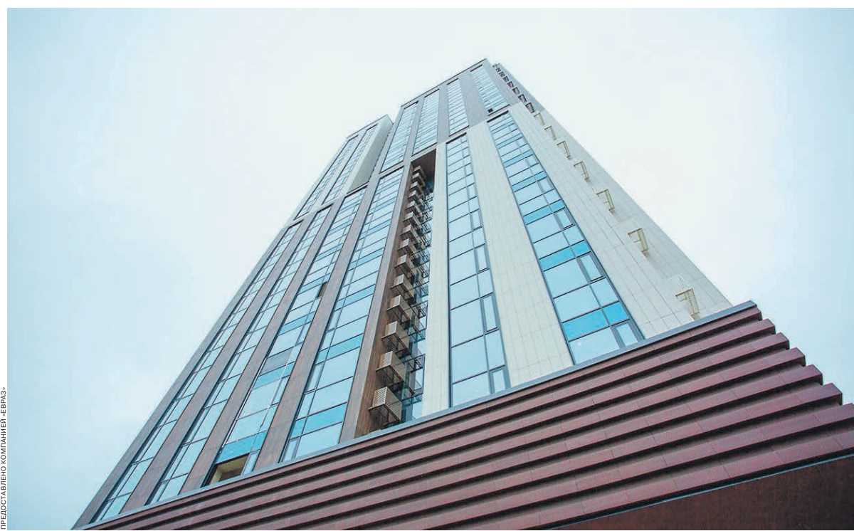
ЖК «Ривер Парк Коломенское» построен с использованием металла, прежде всего двутавровой балки, и типовых решений ЕВРАЗа
