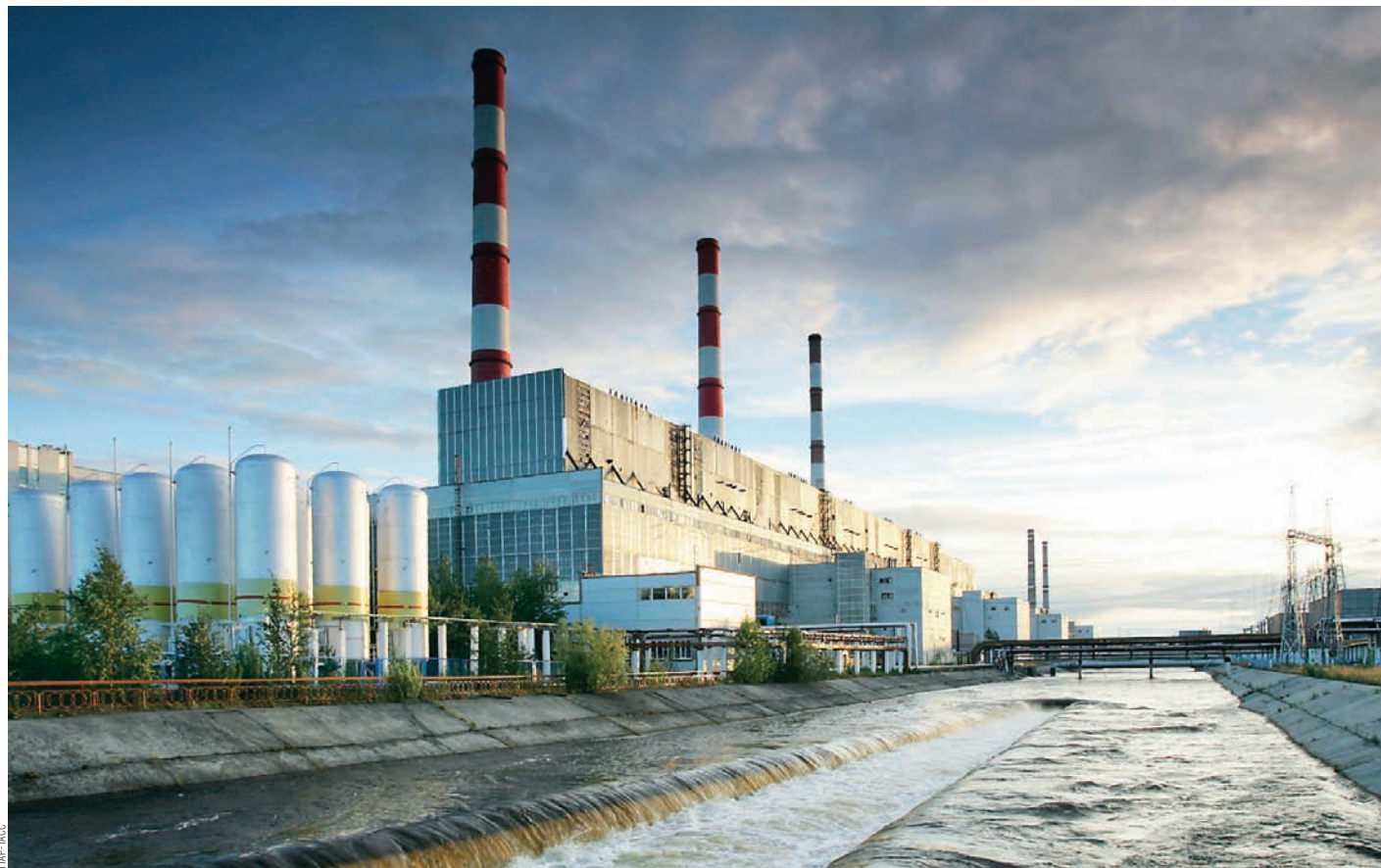
СУРГУТСКАЯ ГРЭС-2 КОНЦЕРНА Е.ON — ОДНА ИЗ НЕМНОГИХ СТАНЦИЙ В РОССИИ, ПОСТРОЕННАЯ ЗАРУБЕЖНЫМ ПОДРЯДЧИКОМ
