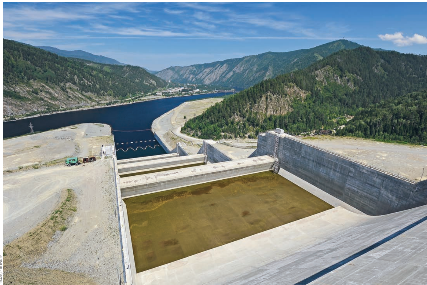
РЕКОНСТРУКЦИЯ ПОСТРАДАВШЕЙ ВО ВРЕМЯ АВАРИИ САЯНО-ШУШЕНСКОЙ ГЭС ЗАСТАВИЛА «РУСГИДРО» ЗНАЧИТЕЛЬНО УВЕЛИЧИТЬ ИНВЕСТИЦИОННУЮ ПРОГРАММУ
