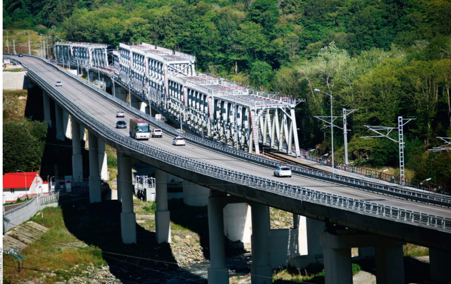
СОВМЕЩЕННАЯ ДОРОГА АДЛЕР—«АЛЬПИКА-СЕРВИС» СВЯЗАЛА БЕРЕГ ЧЕРНОГО МОРЯ С ГОРНЫМИ ВЕРШИНАМИ КРАСНОЙ ПОЛЯНЫ
