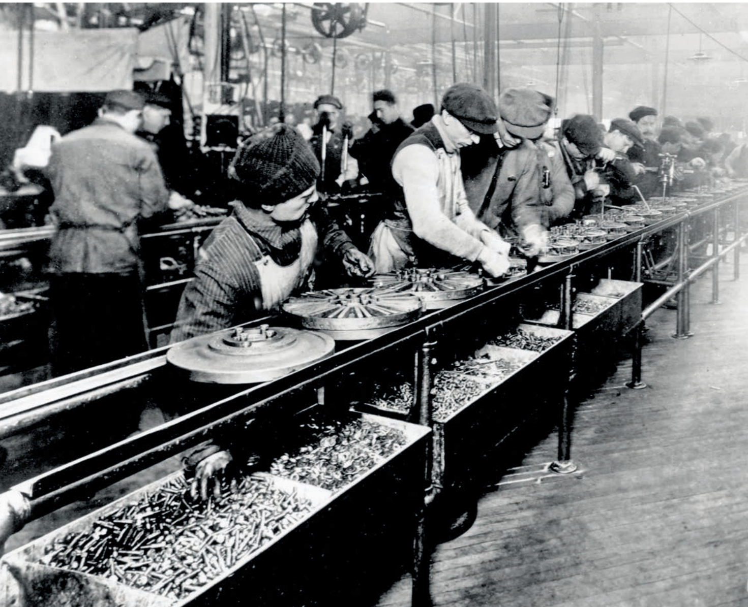
Сборка маховиков на первом движущемся конвейере на заводе Форда в Хайленд-Парк. 1913 год
